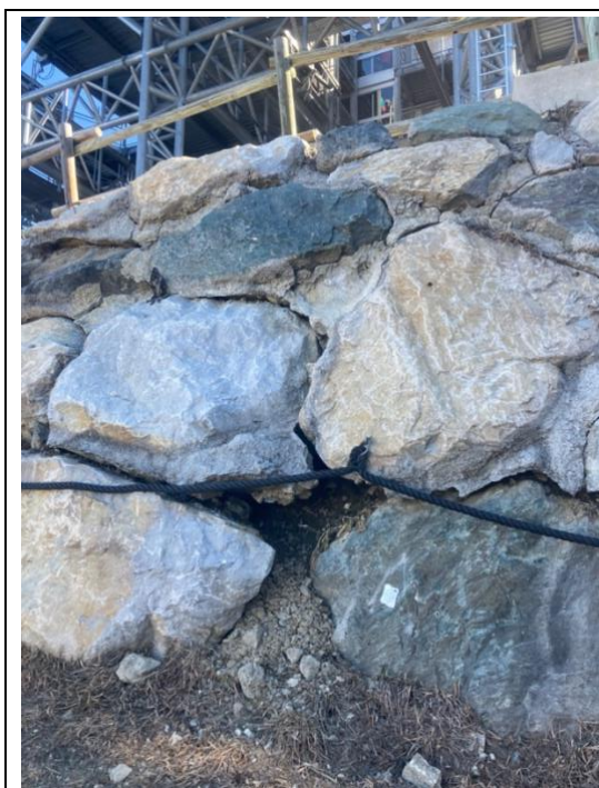
Figure 14 : Dislocation des blocs
