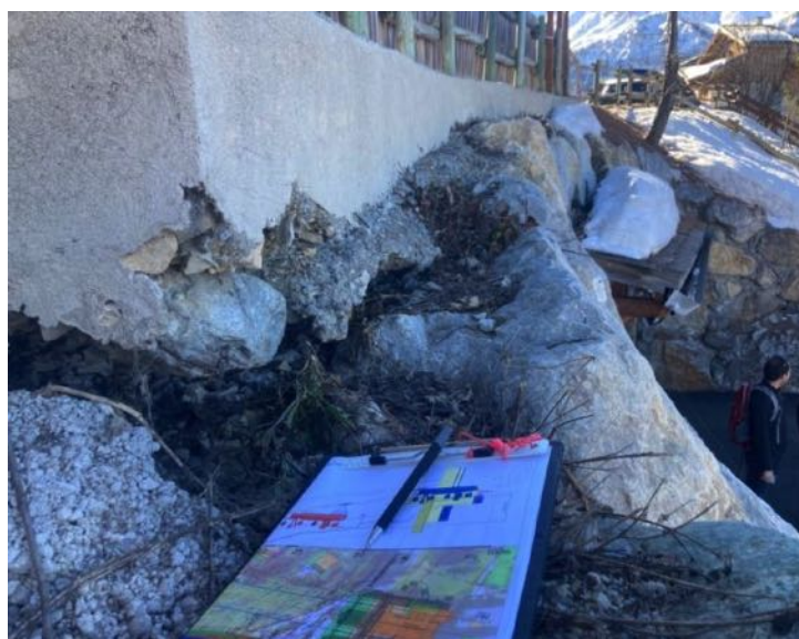
Figure 15 : Affaissement sous la longrine béton
